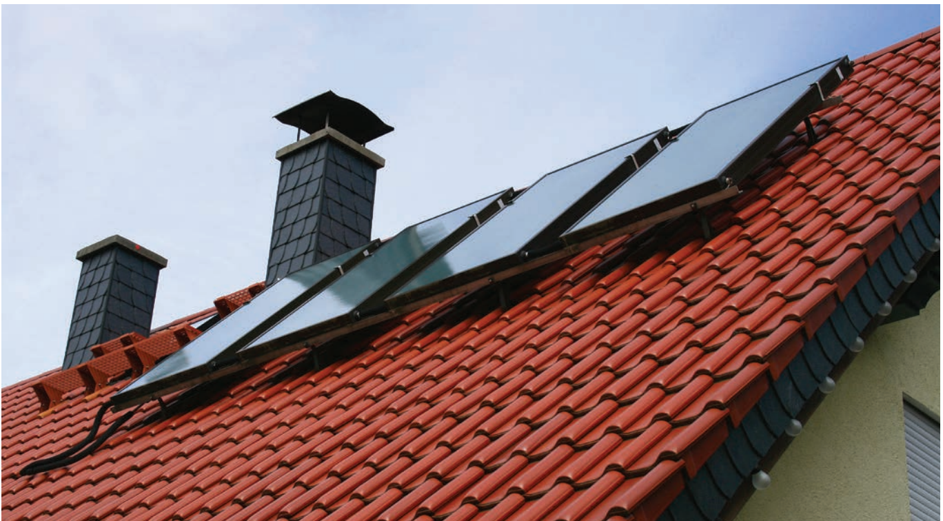
Aurinkopaneelissa DOWCAL™ 200 -nesteeseen perustuva liuos imee auringon lämpöä ja kuljettaa energiaa kohteisiin, joissa sitä voi käyttää ilman tai veden lämmittämiseen.
