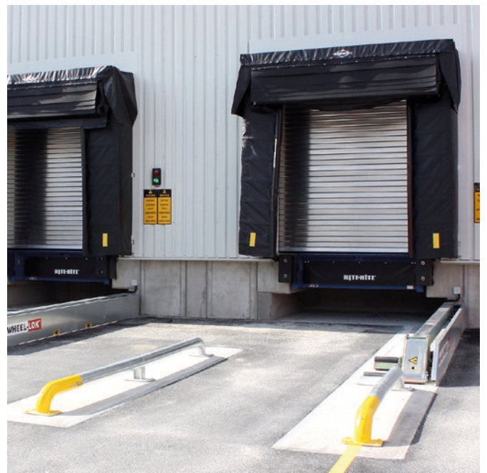
Rengasohjaimet mahdollistavat perävaunun asemoinnin aina keskelle.
