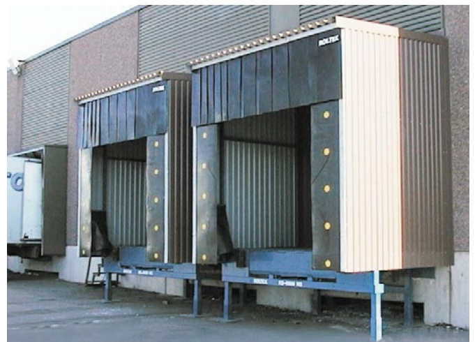
Tiivistet kuormaustilassa, lisävarusteena kulmatyyny.
