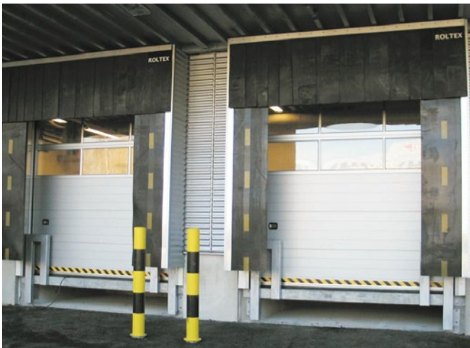
Teräskudosvahvistetut sivuelementit kovaan käyttöön.
