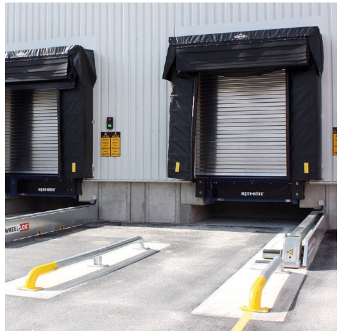
Rengasohjaimet mahdollistavat perävaunun asemoinnin aina keskelle.
