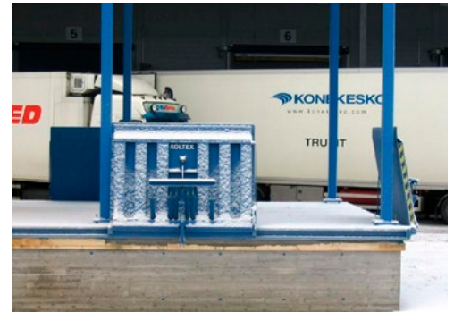
Ohjaukiskolla ja sivusiirtolaitteella varustettu LSJ-kuormaussilta.
